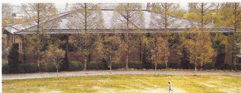
市の施設の屋根に完成した「生駒市民共同発電所1号機」
